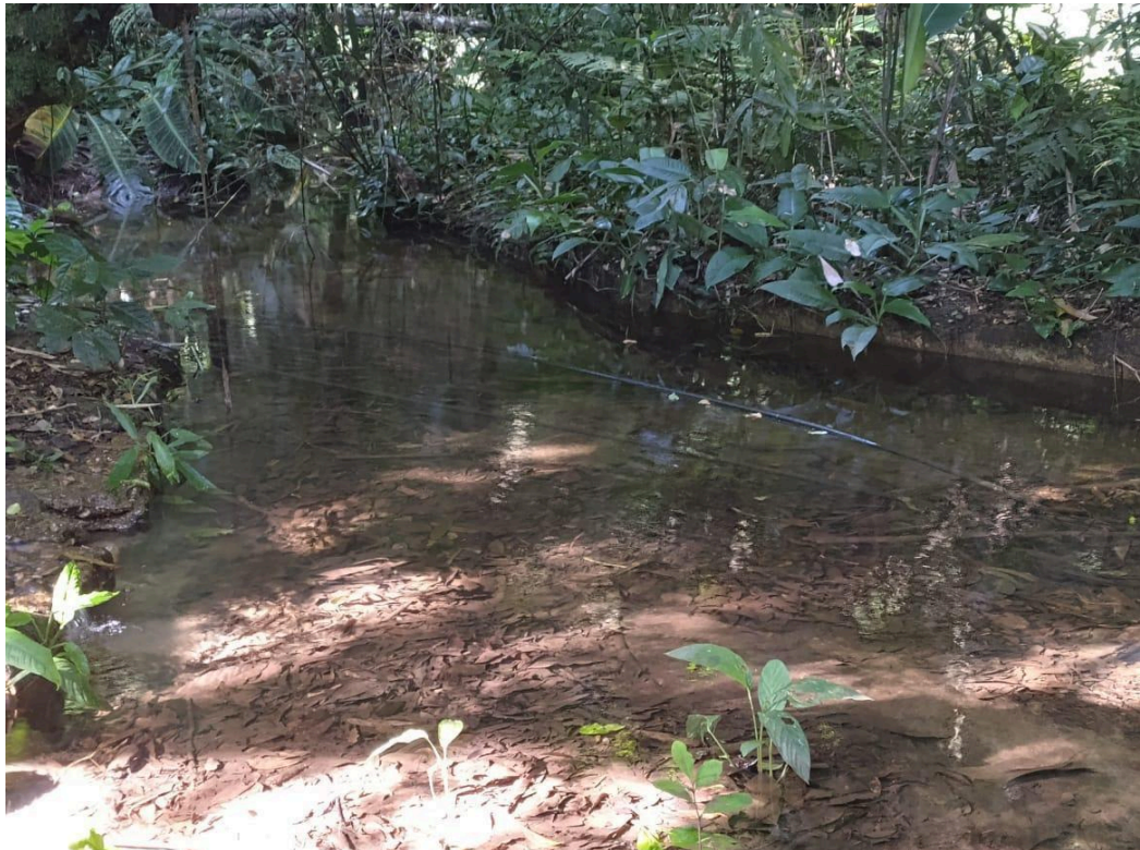
FIGURA 3. Imagem de um trecho da nascente perto da cisterna, com o cano principal.
